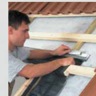
Усиленный дренажный жёлоб, не требующий дополнительной опоры
